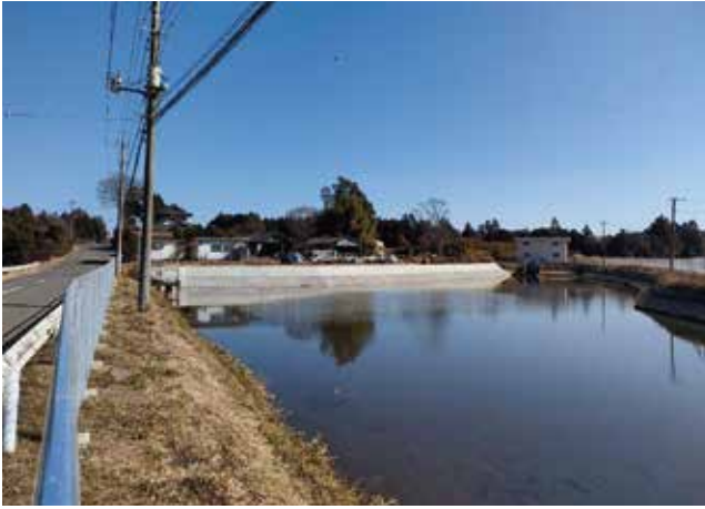
飯前地区茂内池の護岸と浚渫工事を行いました
