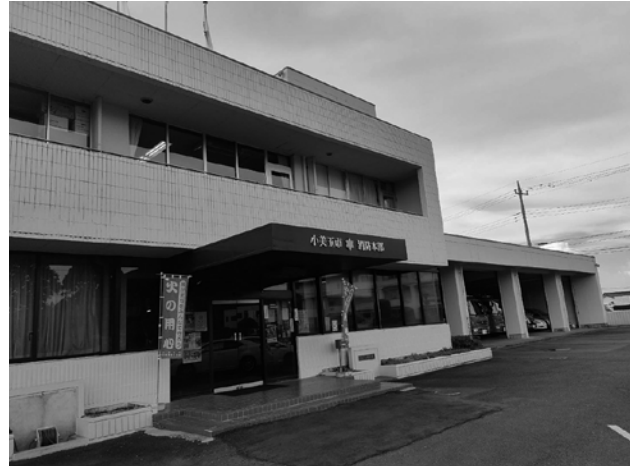
老朽化している消防本部庁舎
