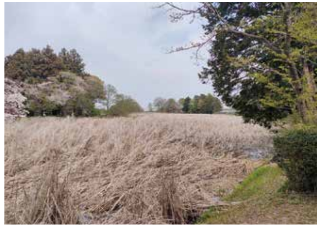
野田地区の半溜池の護岸と浚渫工事を申請しました
