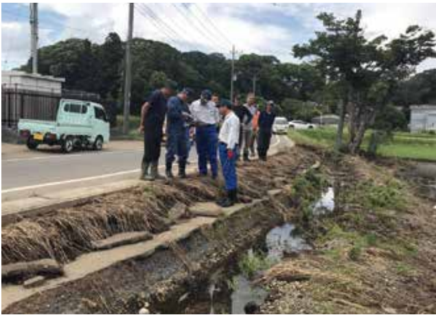
巴川流域の「台風2号」による被害の現地調査
